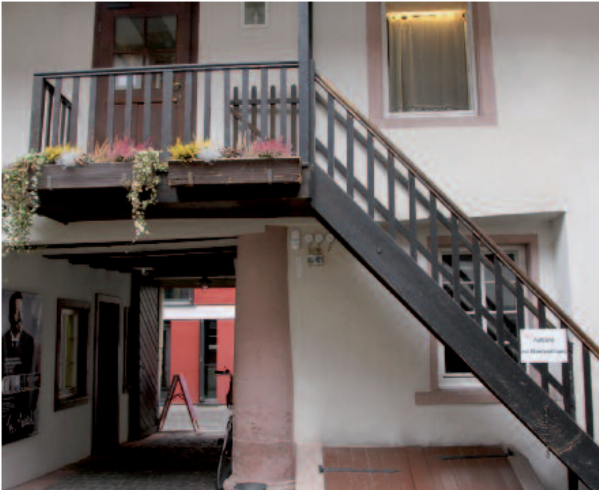
Treppe zur Geburtswohnung Friedrich Eberts.
